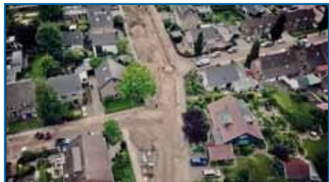
Foto 1 Luchtfoto Weth. Wieggerstr/Gemeint (c) A.Wijenburg
