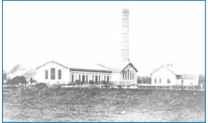
In de tweede Wereldoorlog raakte het gemaal met schoorsteen zwaar beschadigd.
